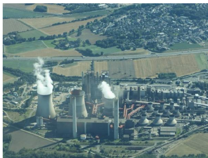
Abbildung 4: Kohlekraftwerk Weisweiler (Foto: IUP).
